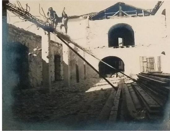
Figura 3. Foto da demolição das paredes e pisos do primeiro pavimento. Fonte: Arquivo Histórico do MHN.
