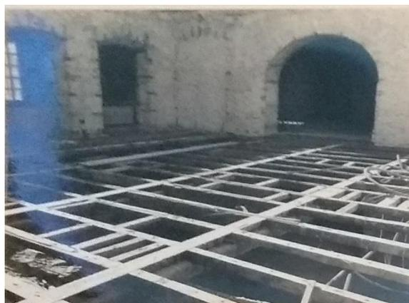
Figura 2. Foto da demolição do piso de madeira do segundo pavimento. Fonte: Arquivo Histórico do MHN.
