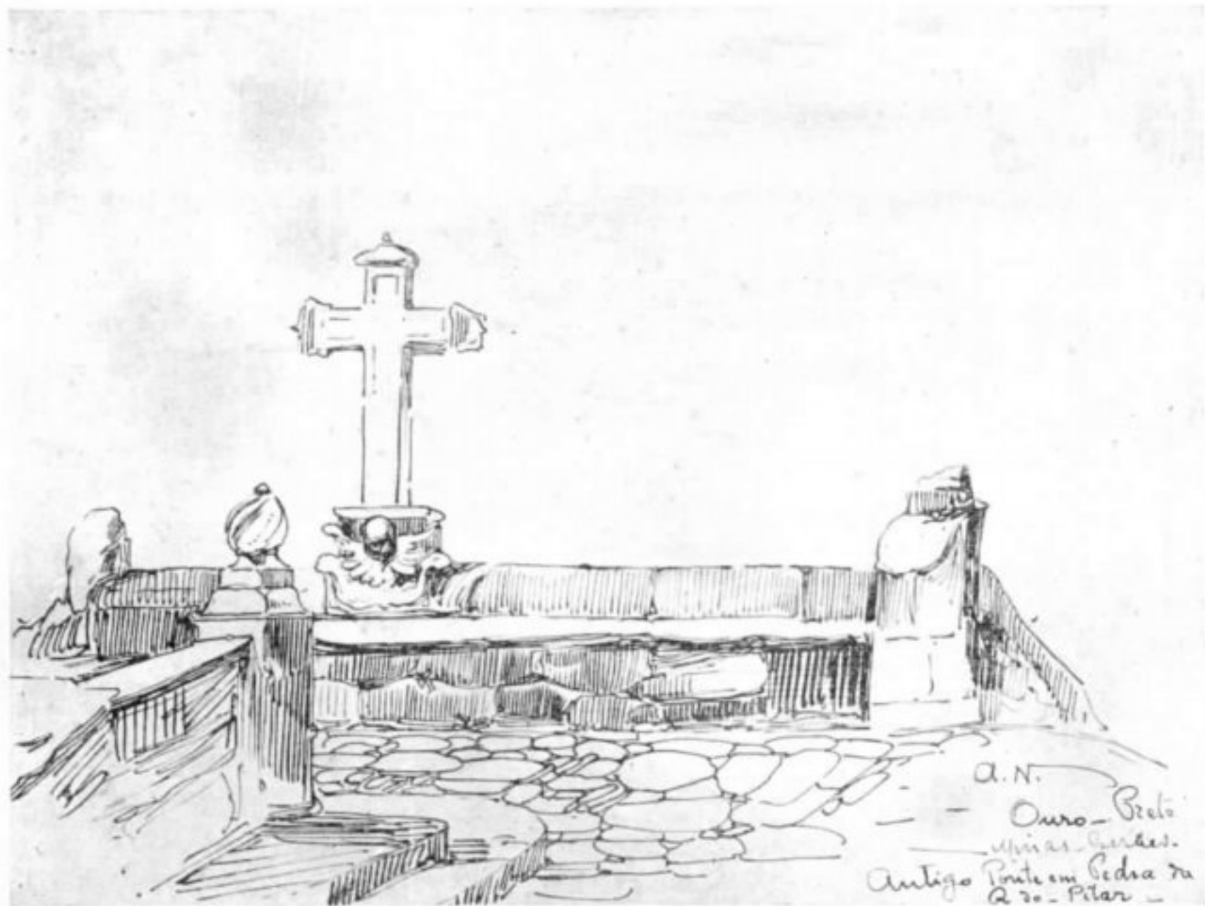
86 — Ponte da rua do Pilar. Ouro Preto. Minas Gerais.
