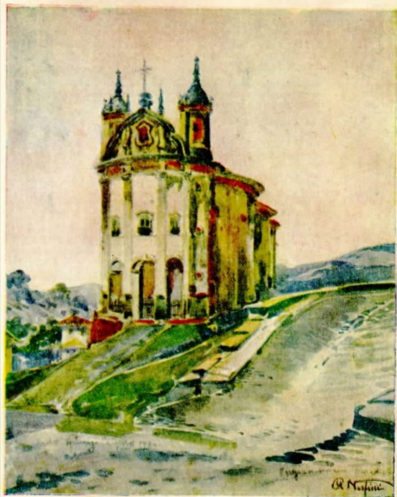
77 — Igreja do Rosário, Ouro Preto, Minas Gerais.
